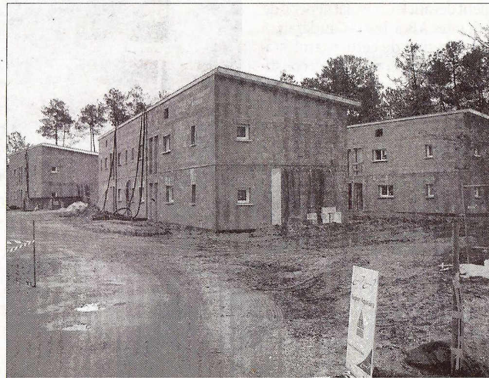
Les projets immobiliers vont bon train dans les deux villes. PH. O. D.
