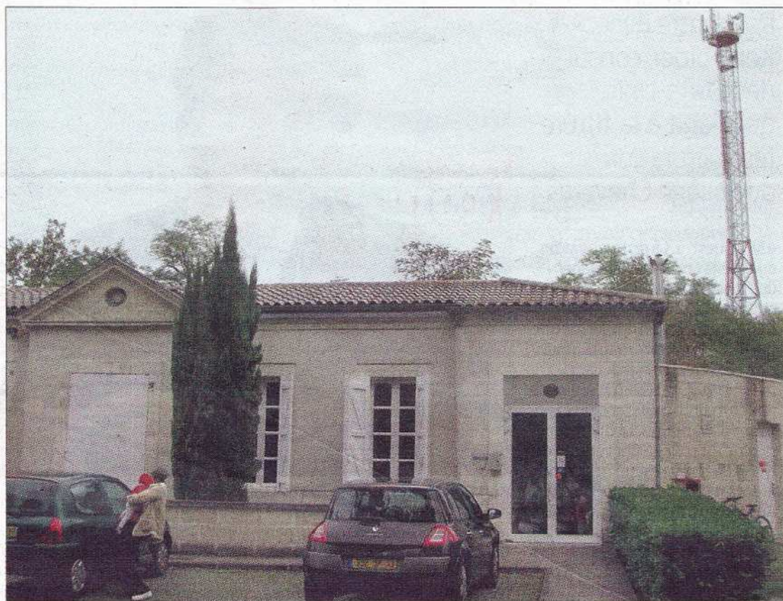
Le pylône est à quelques mètres seulement de la crèche Brin d'Malice. PHOTO O. D.
